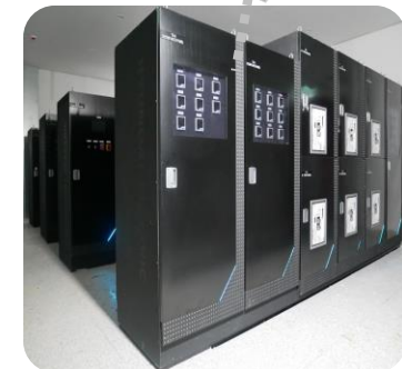
◇ ±750Vdc 배전반 및 380Vdc 분전반
